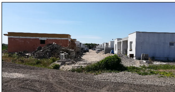
Obr. 10 Výstavba obytnej zóny na Varjašskej ul.
