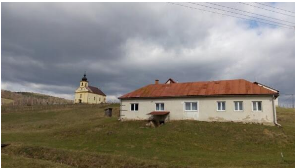
Pohľad na kultúrny dom pred rekonštrukciou
