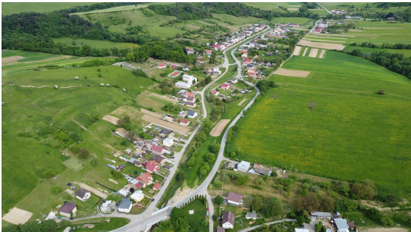
OBR. č. 7- Pohľad na obec Želmanovce smer Kuková (Interný zdroj)
