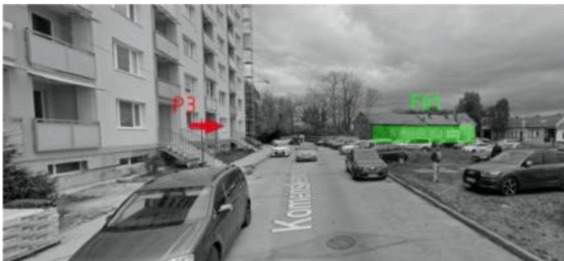
▪ Obr 4. Fotografia riešeného územia fasáda F01 bez okien
