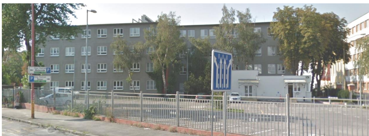
Obr.10 Južná fasáda administratívnej budovy na parcele č.9145/1
