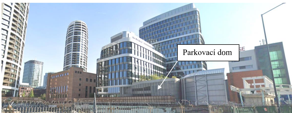
Obr.6 Pohľad na Administratívnu budovu CO2
