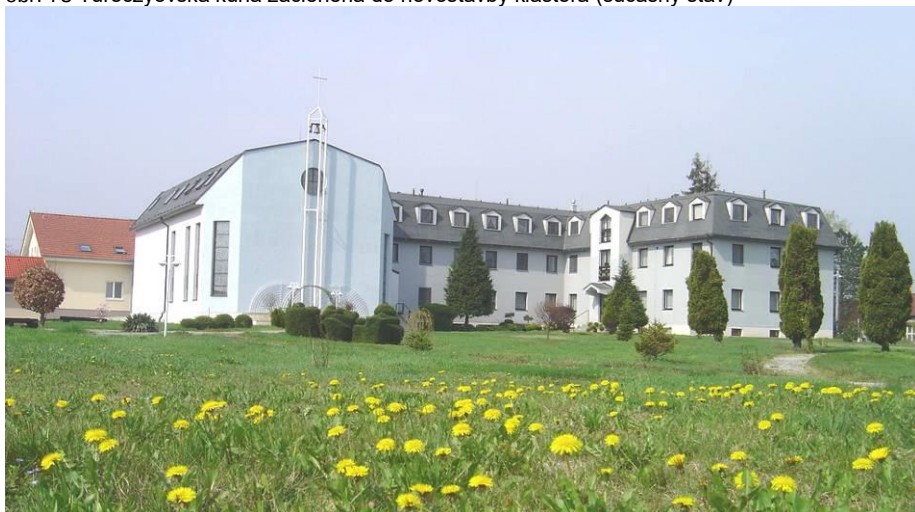
obr. 73 Turóczyovská kúria začlenená do novostavby kláštora (súčasný stav)
