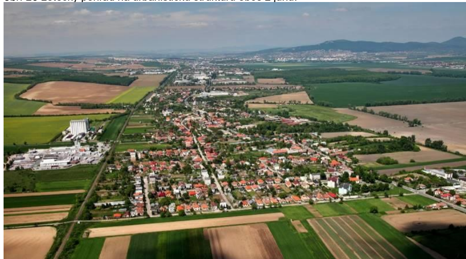
obr. 26 Letecký pohľad na urbanistickú štruktúru obce z juhu.
