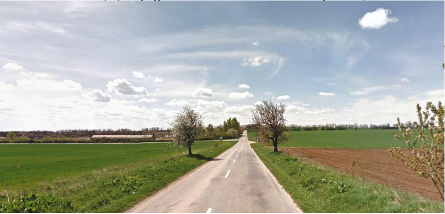
obr. 91 Cesta III/1660 (západný výjazd z katastra obce smerom na Mojmírovce)
