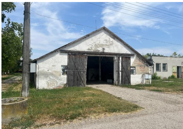
Foto 1 – pohľad objekt, ktorý bude rekonštruovaný na OMD
