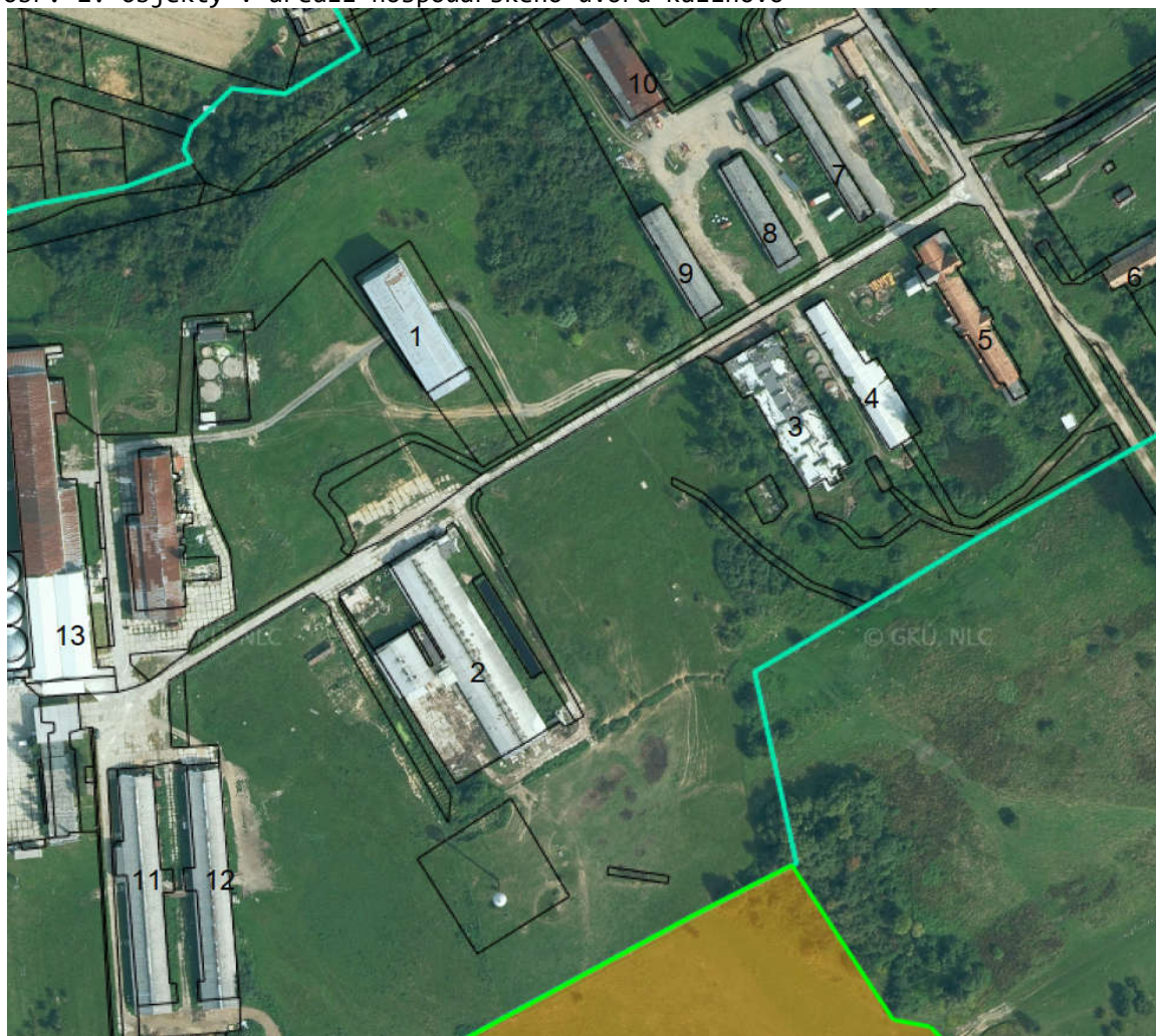
Obr. 2: Objekty v areáli hospodárskeho dvora Kalinovo
