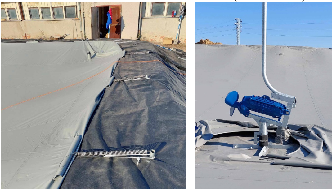
Obr.19: Ilustrácia kotvenia vaku a inštalácie vnútorného miešadla (lokalita Ladmovce)
