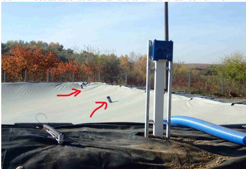
Obr.21: Ilustrácia odvetrávania vaku a monitorovací box CEMS
