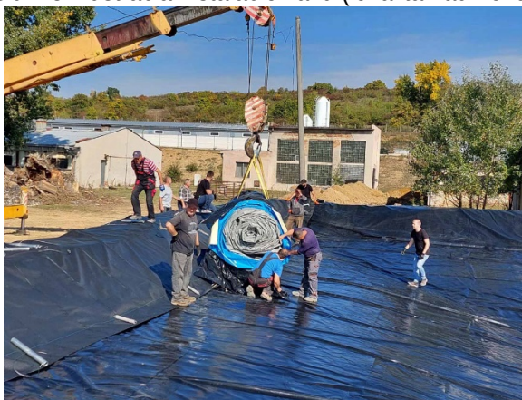
Obr.18: Ilustrácia inštalácie vaku (lokalita Ladmovce)
