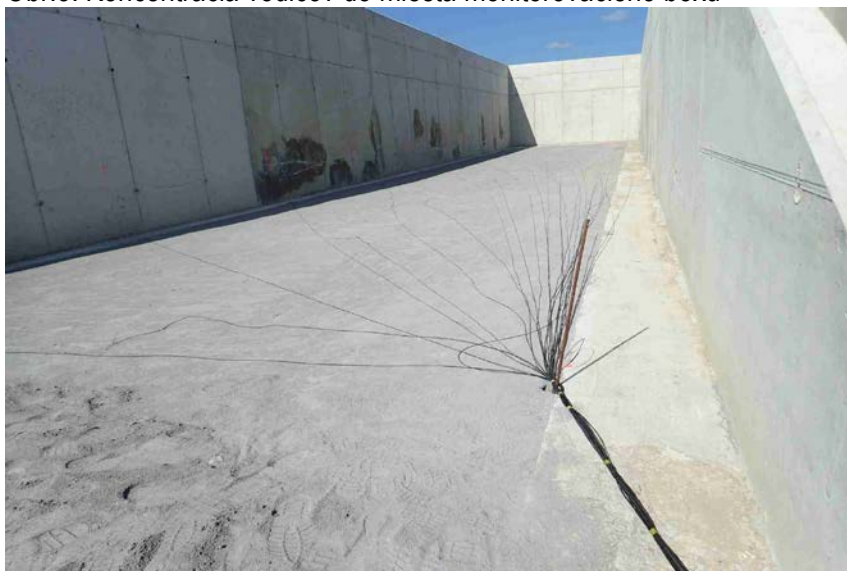
Obr.3: Koncentrácia vodičov do miesta monitorovacieho boxu
