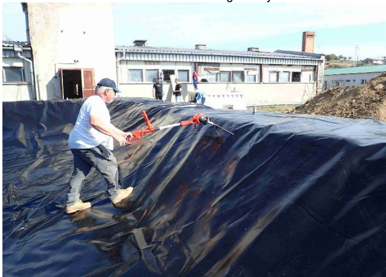
Obr.13 Kontrola tesnosti fólie elektromagnetickým testerom – vak na hnojovicu
