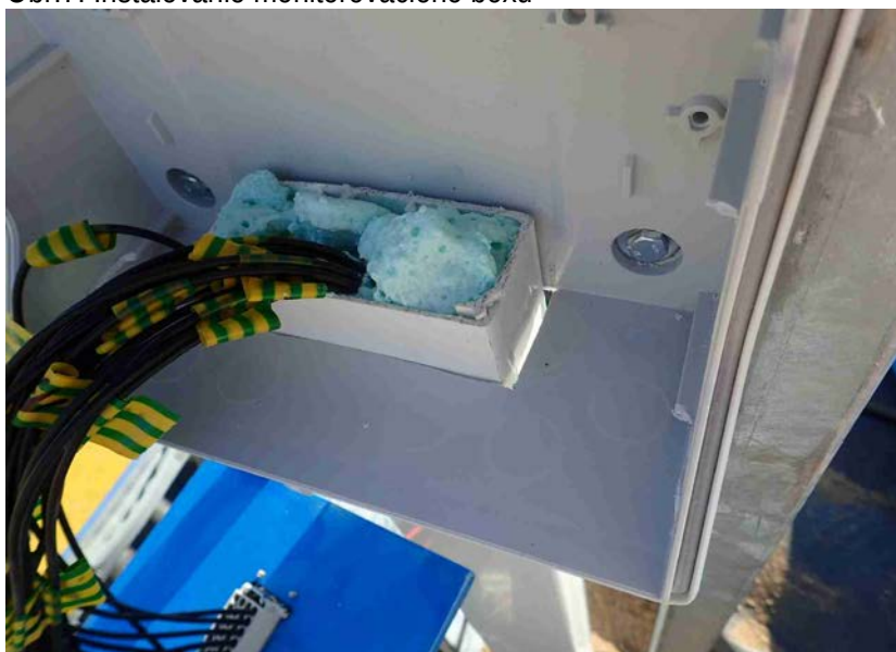
Obr.7: Inštalovanie monitorovacieho boxu
