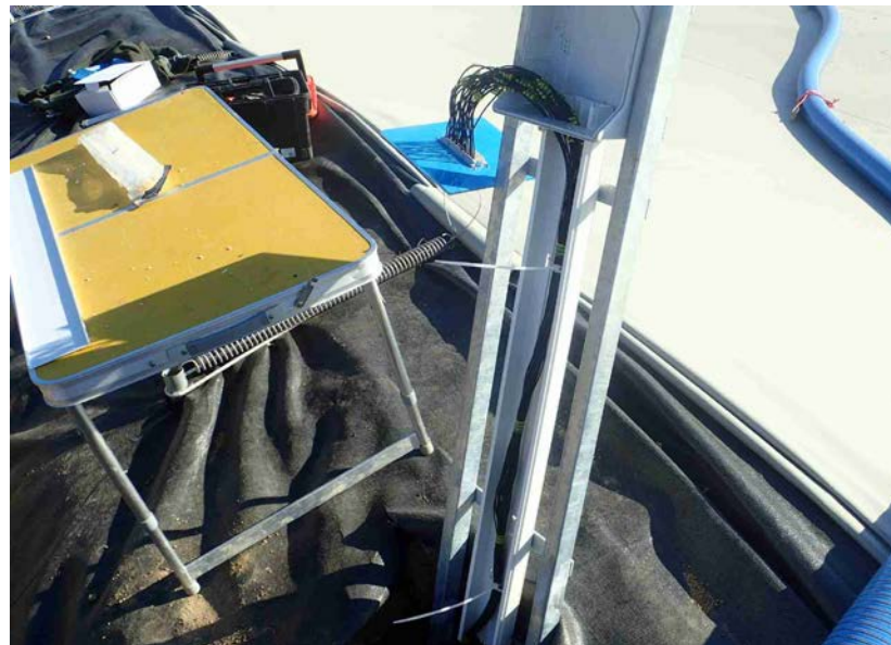
Obr.6: Inštalovanie monitorovacieho boxu
