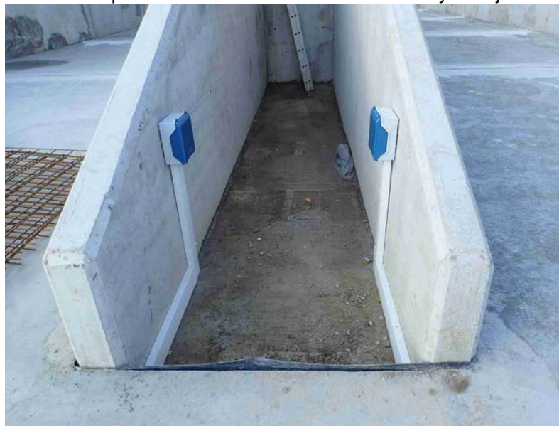
Obr.10: Kompletne nainštalované monitorovacie boxy - hnojisko
