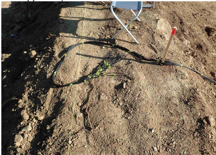
Obr.5: Vytyčovanie polôh snímačov, inštalácia snímačov a vodičov
