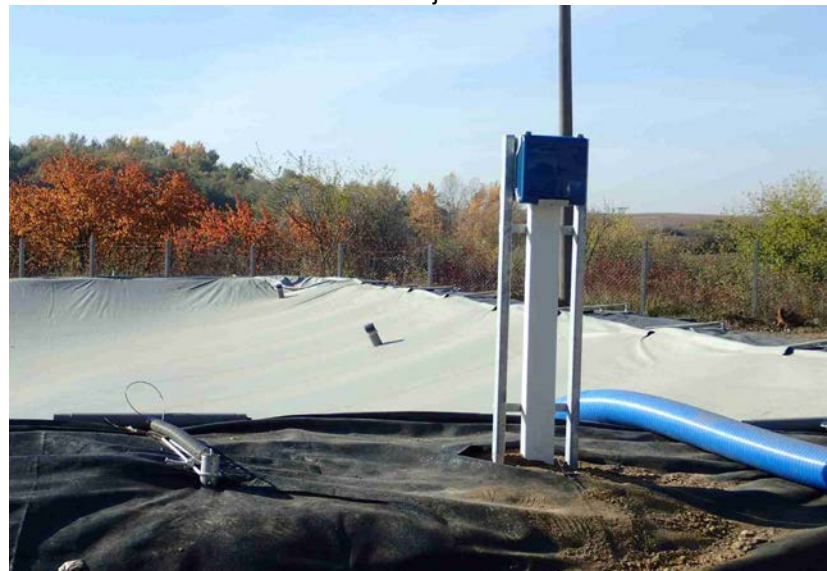
Obr.6 Monitorovací box vaku na hnojovicu
