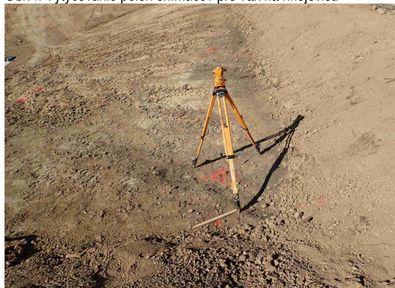
Obr.4: Vytyčovanie polôh snímačov pre vak na hnojovicu
