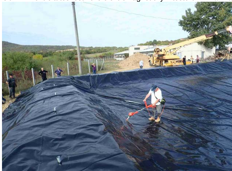
Obr.12: Kontrola tesnosti fólie elektromagnetickým testerom – vak na hnojovicu
