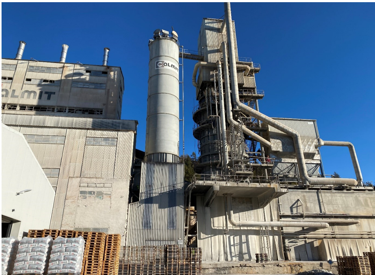
Obrázok č. 2: Súprúdna regeneratívna dvojšachtová pec č. 5 CIMPROGETTI
