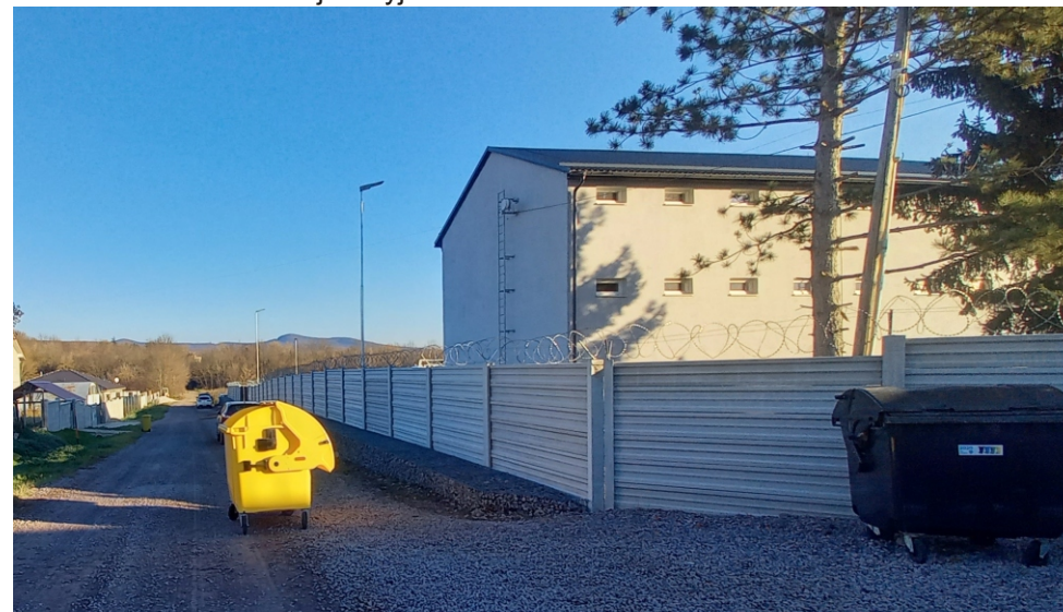
Obr.4: Pohľad na areál z ulice Čerešňová
