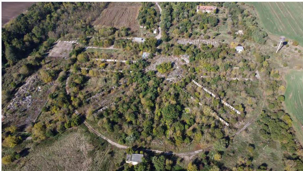
Areál pre zahájením búracích prác
