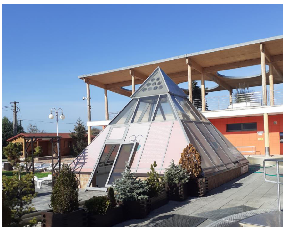
Obr. 3 Objekt geotermálneho vrtu Po-1 v areáli termálneho kúpaliska Podhájska
