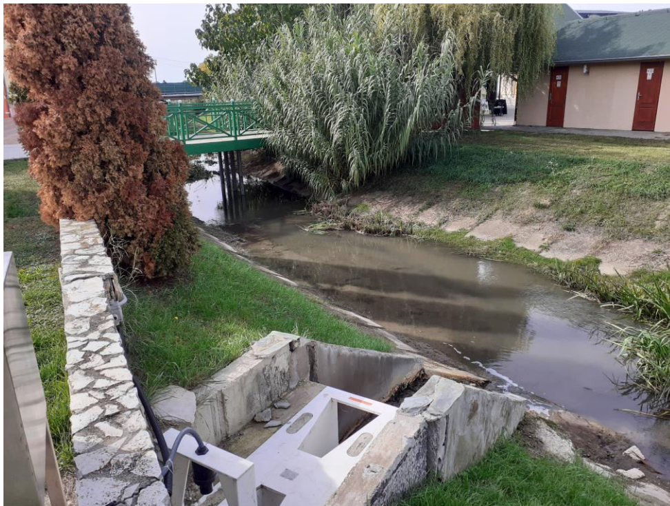
Obr. 5 Miesto výpustného objektu 2
