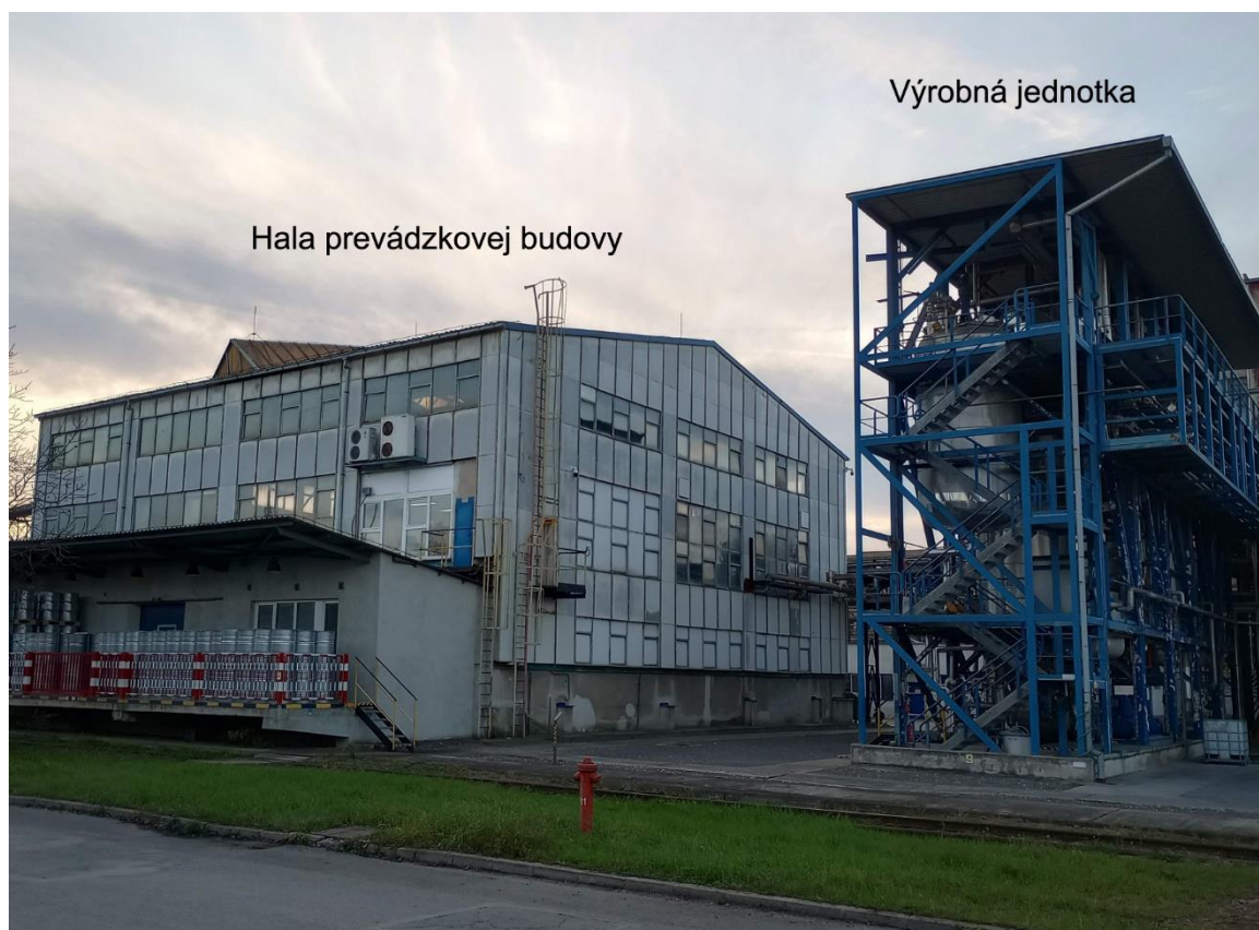
Obr. 1: Prevádzková budova (obj. č. 5217)
