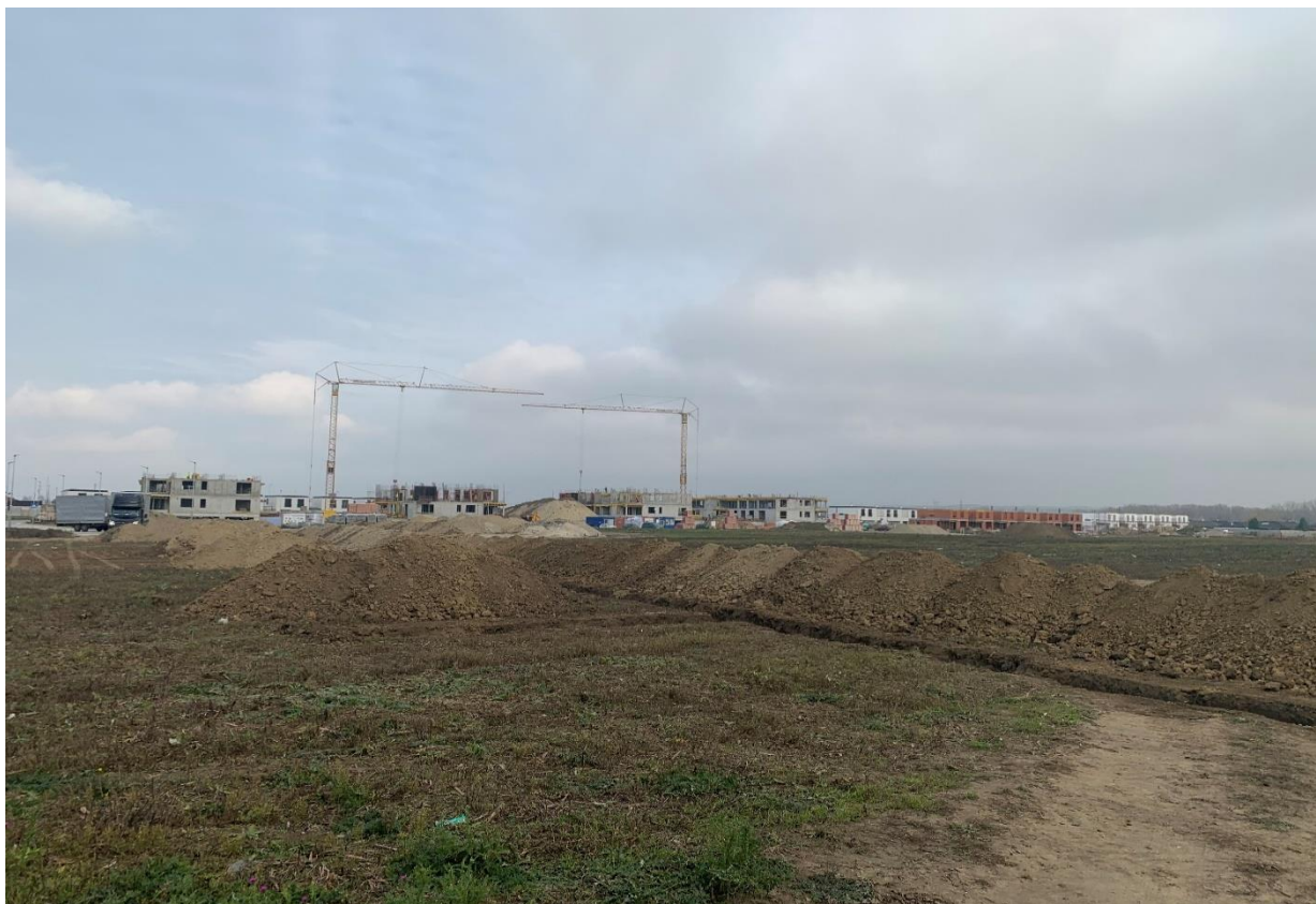
Pohľad z juhu na severovýchod, prebiehajúca výstavba Obytného súboru I. etapy
