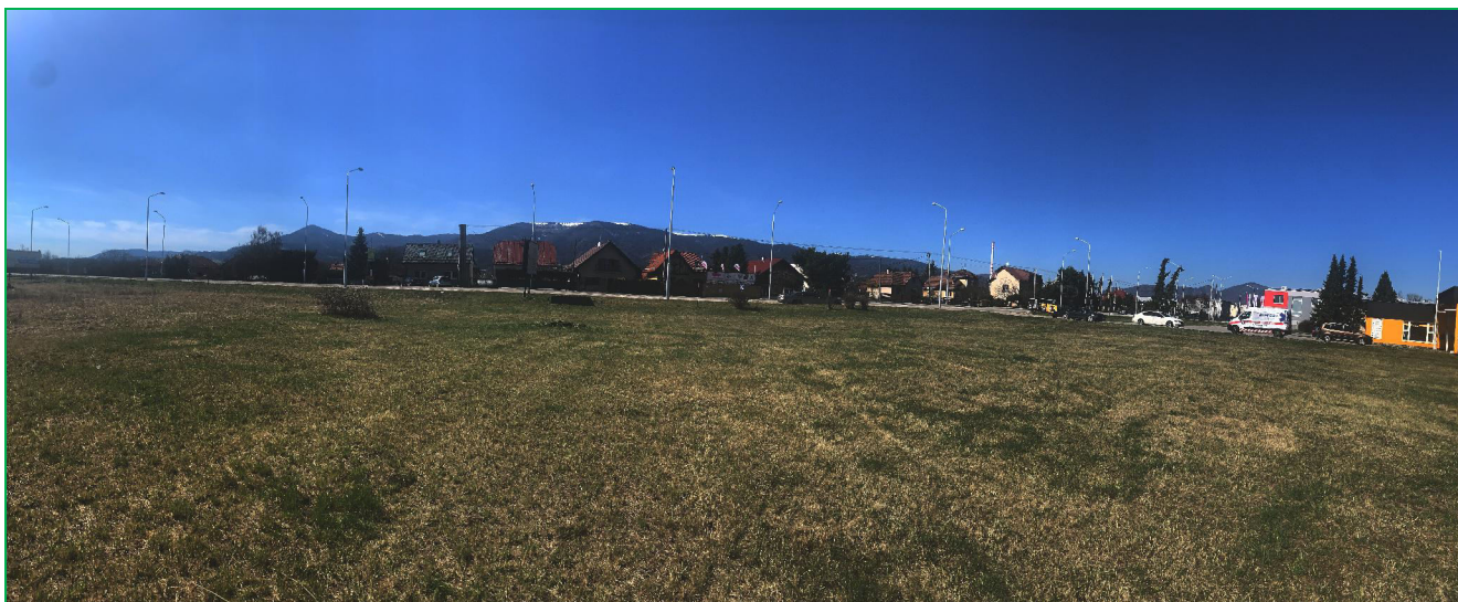
Obr. 2.8 Pohľad na záujmové územie výstavby z východnej strany
