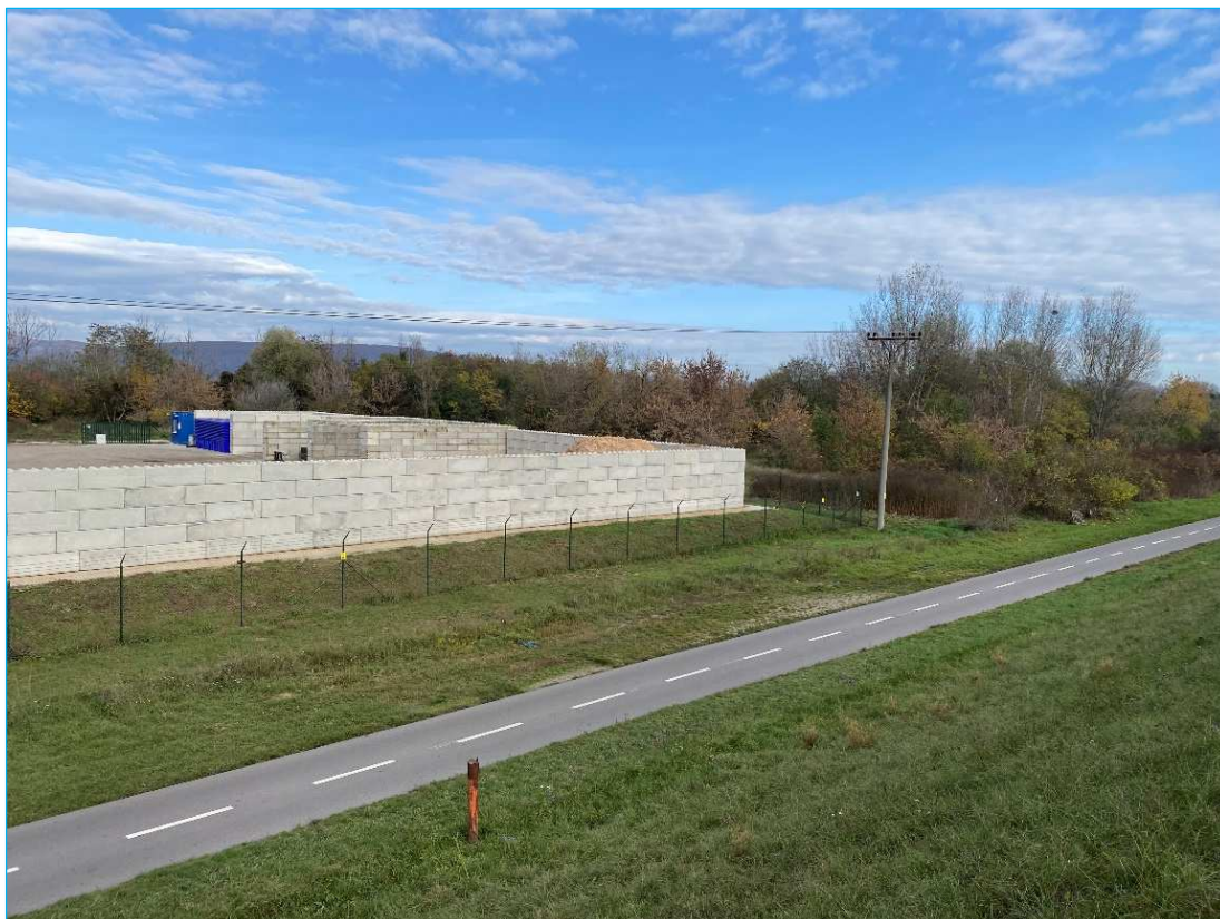
Obr. č. 1: Fotografia V strany oplotenia areálu smerom k záhradkárskej osade
