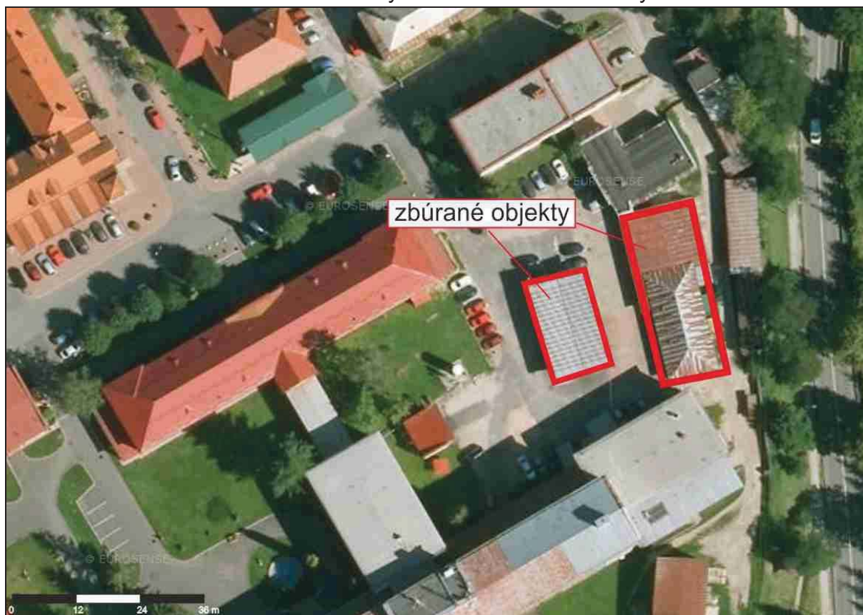
Obr. 7 Areál nemocnice - zbúrané objekty v mieste výstavby parkovacieho domu (www.mapy.cz)
