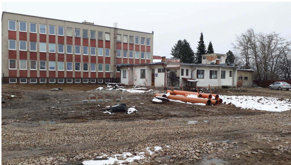
Obr. 2 Pohľad na stavenisko - miesto budúceho parkovacieho domu
