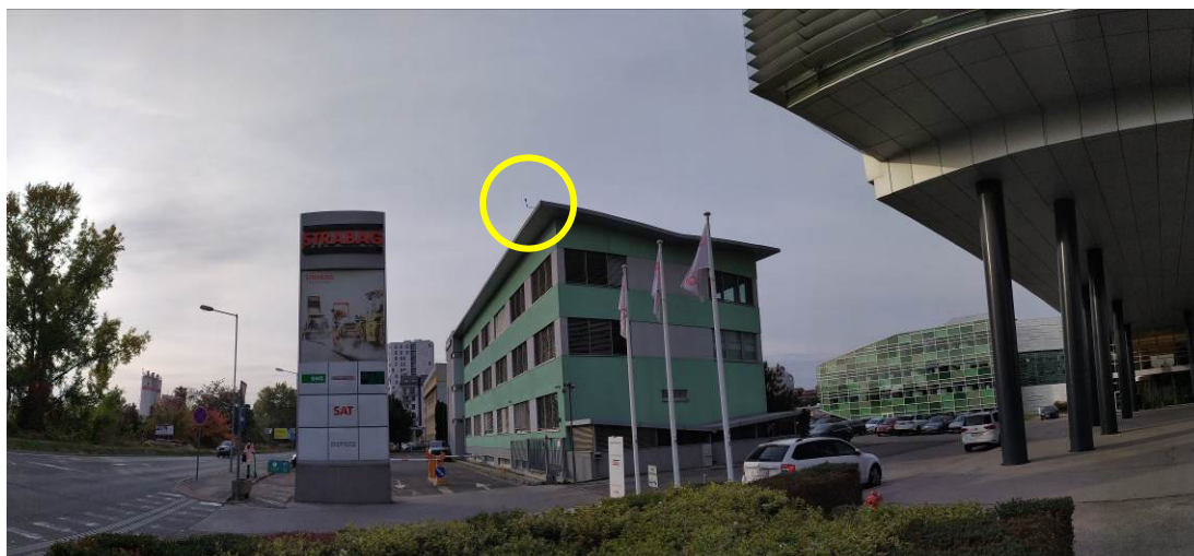
Obr. 29 pohľad na merací bod na streche budovy Fyzio Klinik
