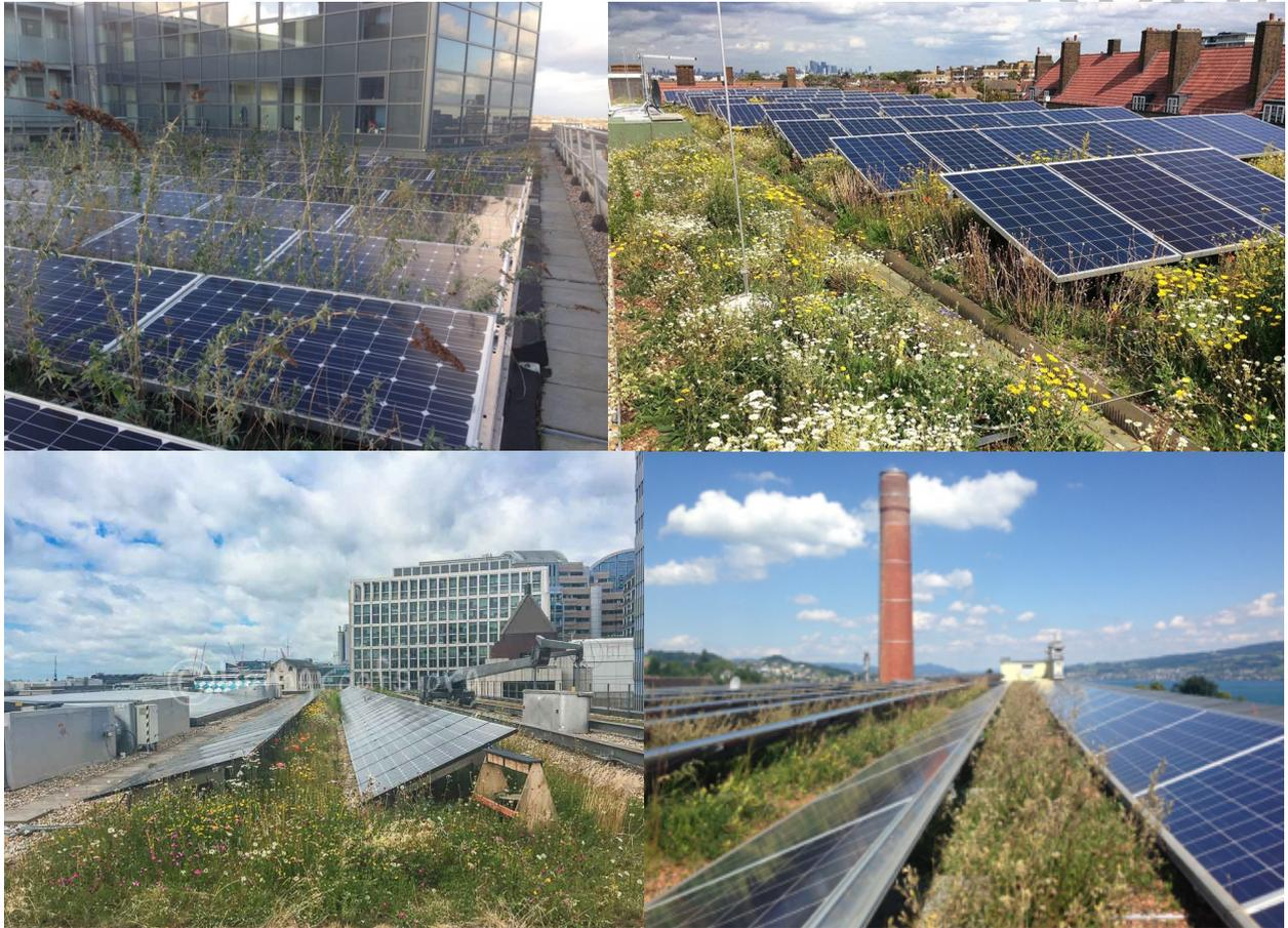
Zelené strechy sú efektívnou strešnou krytinou s výbornými izolačnými vlastnosťami, čím prirodzene prispievajú k zabezpečeniu optimálnych vnútorných podmienok bez energetických dotácií; fotovoltaická elektrárňa navyše znižuje energetickú závislosť a prispieva k pozitívnej energetickej bilancii. Vďaka vegetačnému povrchu sa súčasne územie nestáva tepelným ostrovom, s dažďovými vodami sa prirodzene nakladá.
