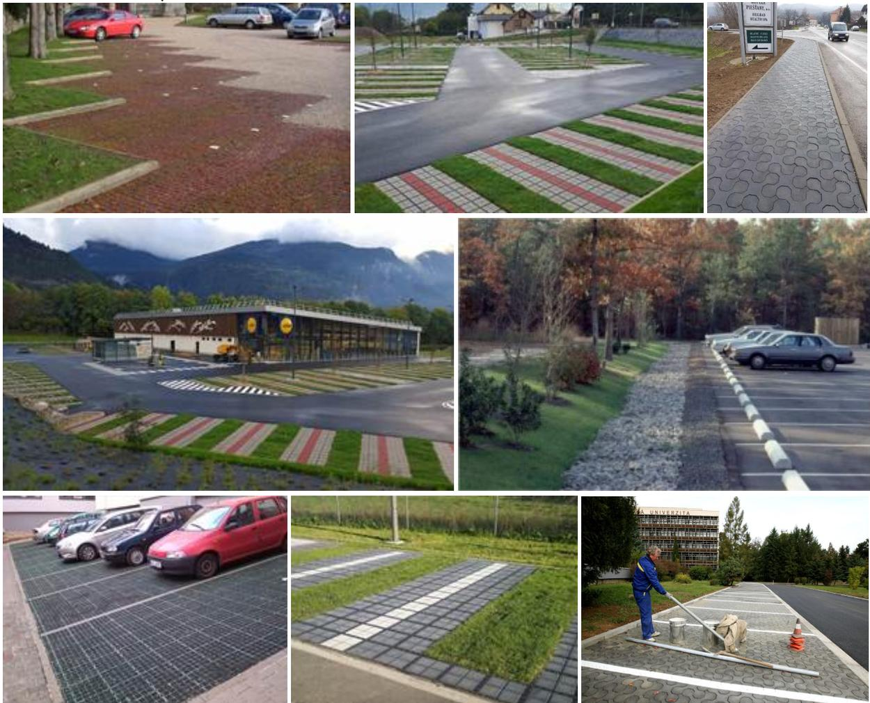
Zelené strechy parkovísk a iných vodorovných stavieb a spevnených plôch zabezpečujú bezpečné nakladanie s dažďovými vodami z povrchového odtoku prirodzenou plošnou infiltráciou do podlažia, čím prispievajú k zachovaniu vody v území, zachovaniu prirodzenej vodnej bilancie ako aj predchádzajú prehrievaniu územia a vzniku tepelných ostrovov; sú prirodzeným a efektívnym protipovodňovým opatrením.
