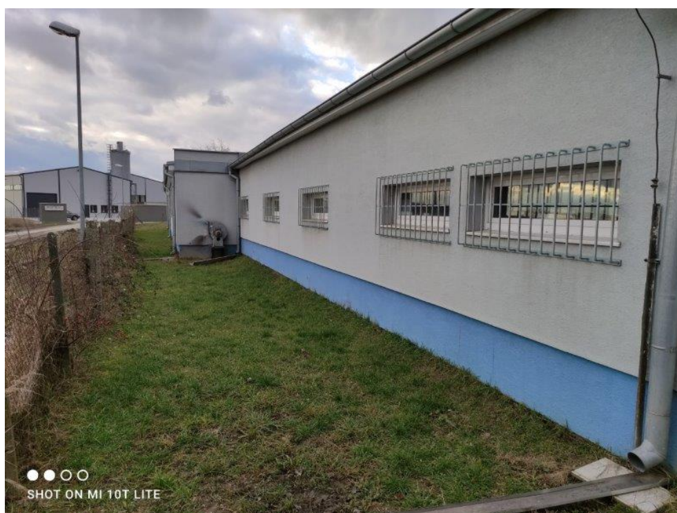
Obr. 1: Pohľad na južnú fasádu jestvujúceho riešeného objektu
