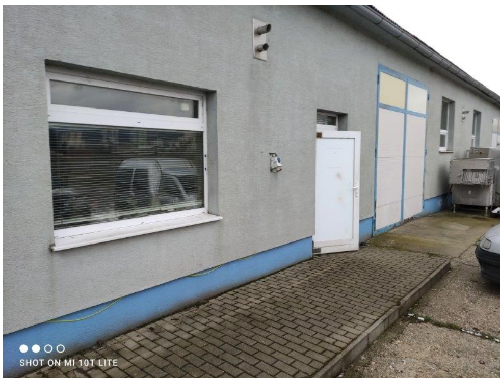
Obr. 2: Pohľad na časť severnej fasády jestvujúceho riešeného objektu
