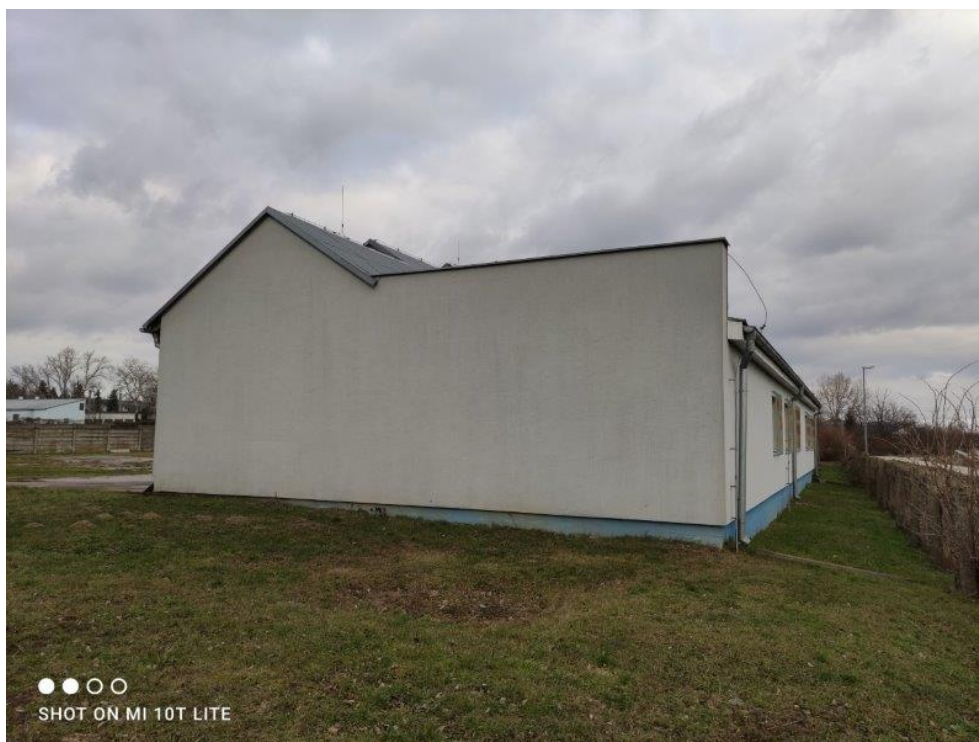
Obr. 6: Pohľad na západnú fasádu riešeného objektu
