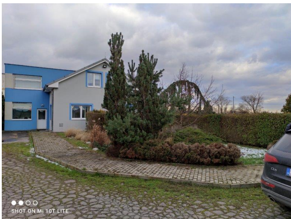
Obr. 3: Pohľad na jestvujúce sadové úpravy v riešenom areáli
