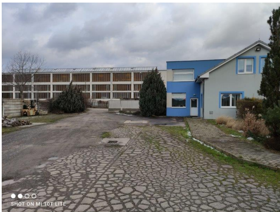
Obr. 4: Pohľad na vjazd do areálu z dvora
