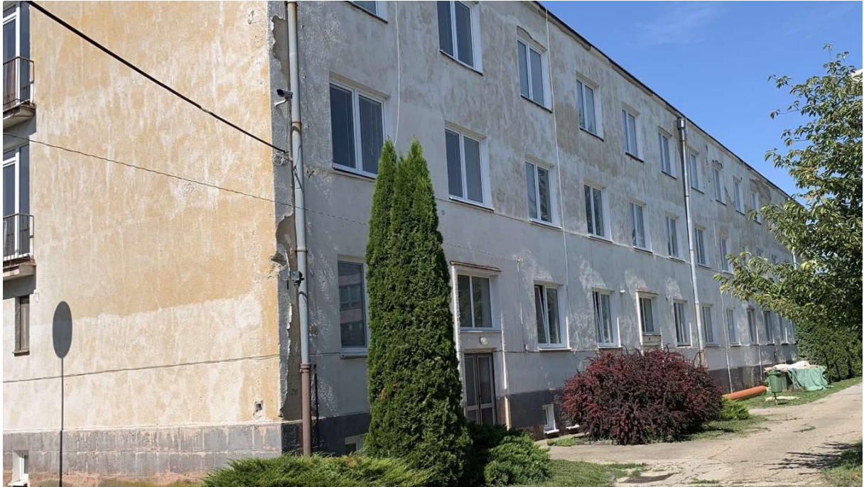
Pohľad na budovu z nezateplenej časti.
