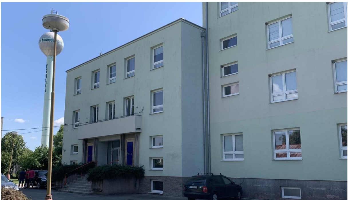
Pohľad na budovu z priechelia, zateplená časť.
