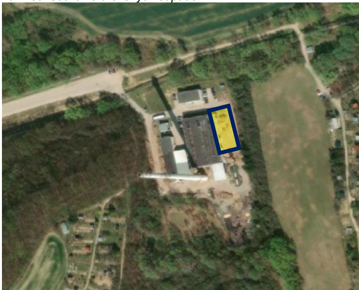
Obr. 3: Detailný pohľad na plochu v rámci areálu navrhovateľa pre parkovanie a prvý výkon činnosti mobilného
