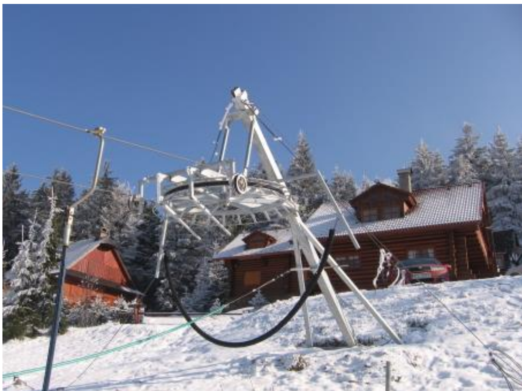
12 Navrhovaná zmena - prenosný lyžiarsky vlek typu „Školní 300“, vrcholová (vratná) stanica Zdroj: http://www.vleky.cz/
