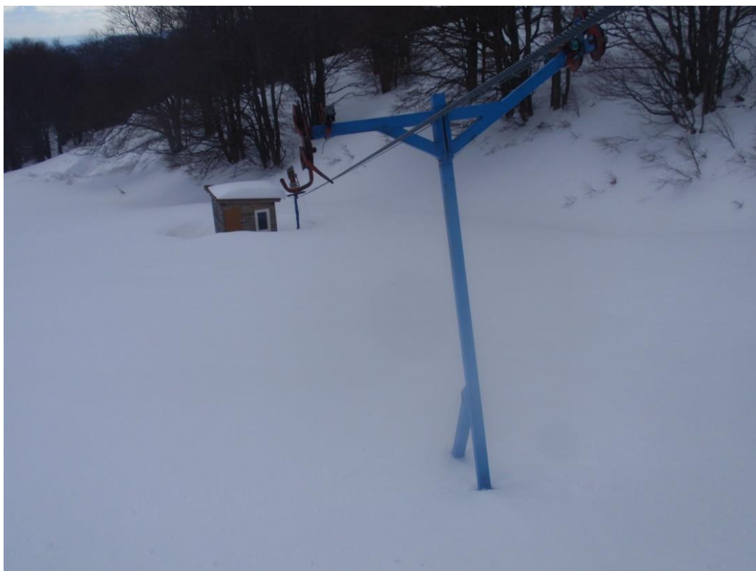
5 Lyžiarsky vlek TATRAPOMA EPV 300 Kráľova studňa, údolná stanica – súčasný stav (marec 2022) Zdroj: Hotel Kráľova studňa
