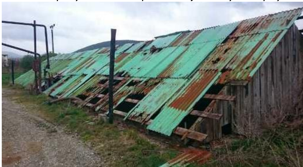
Obr. 2: Súčasný prekrytie nádrží na odseparovanú hnojovicu od výkrmu ošípaných
