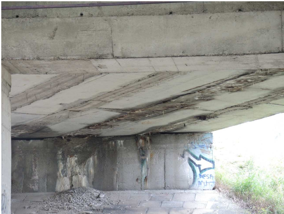
Most 18-383 cez železničnú trať č.180 Žilina – Košice
