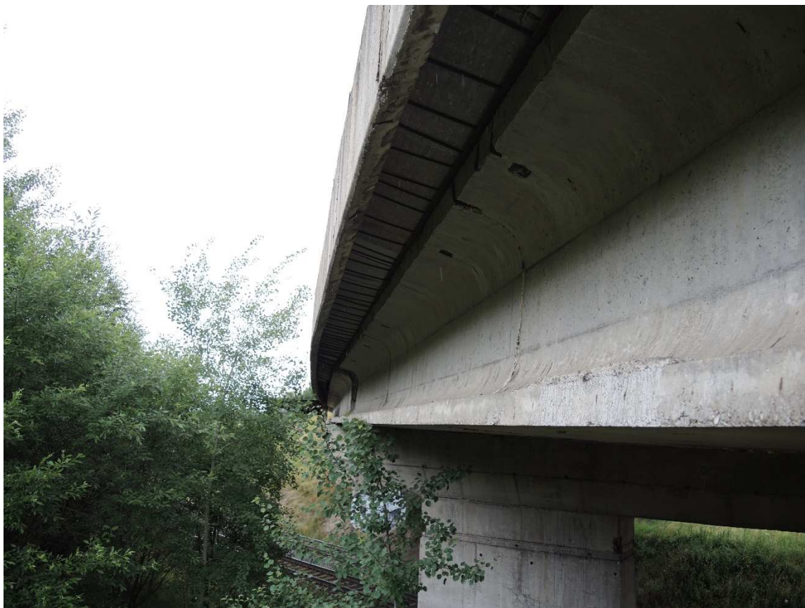
Most 18-383 cez železničnú trať č.180 Žilina – Košice
