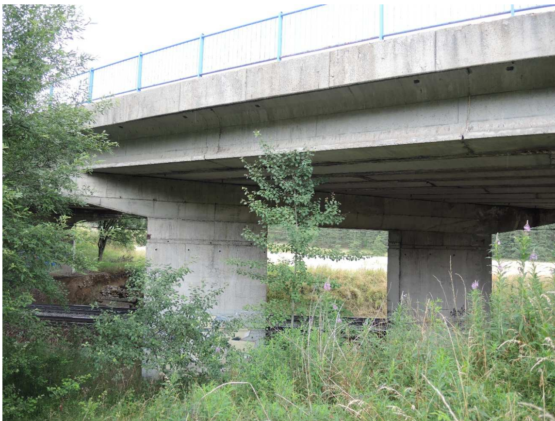
Most 18-383 cez železničnú trať č.180 Žilina – Košice
