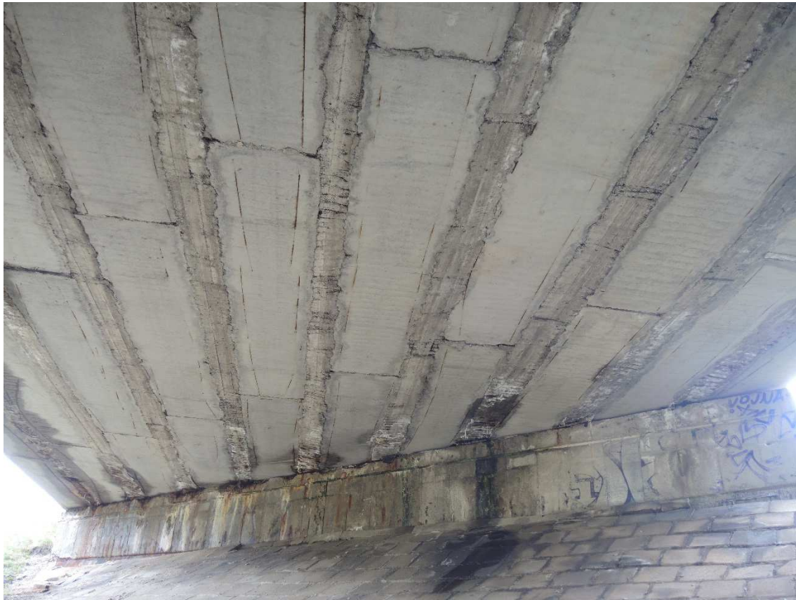
Most 18-383 cez železničnú trať č.180 Žilina – Košice
