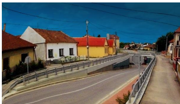
Obrázok 42 Podjazd pod železničnú trať
