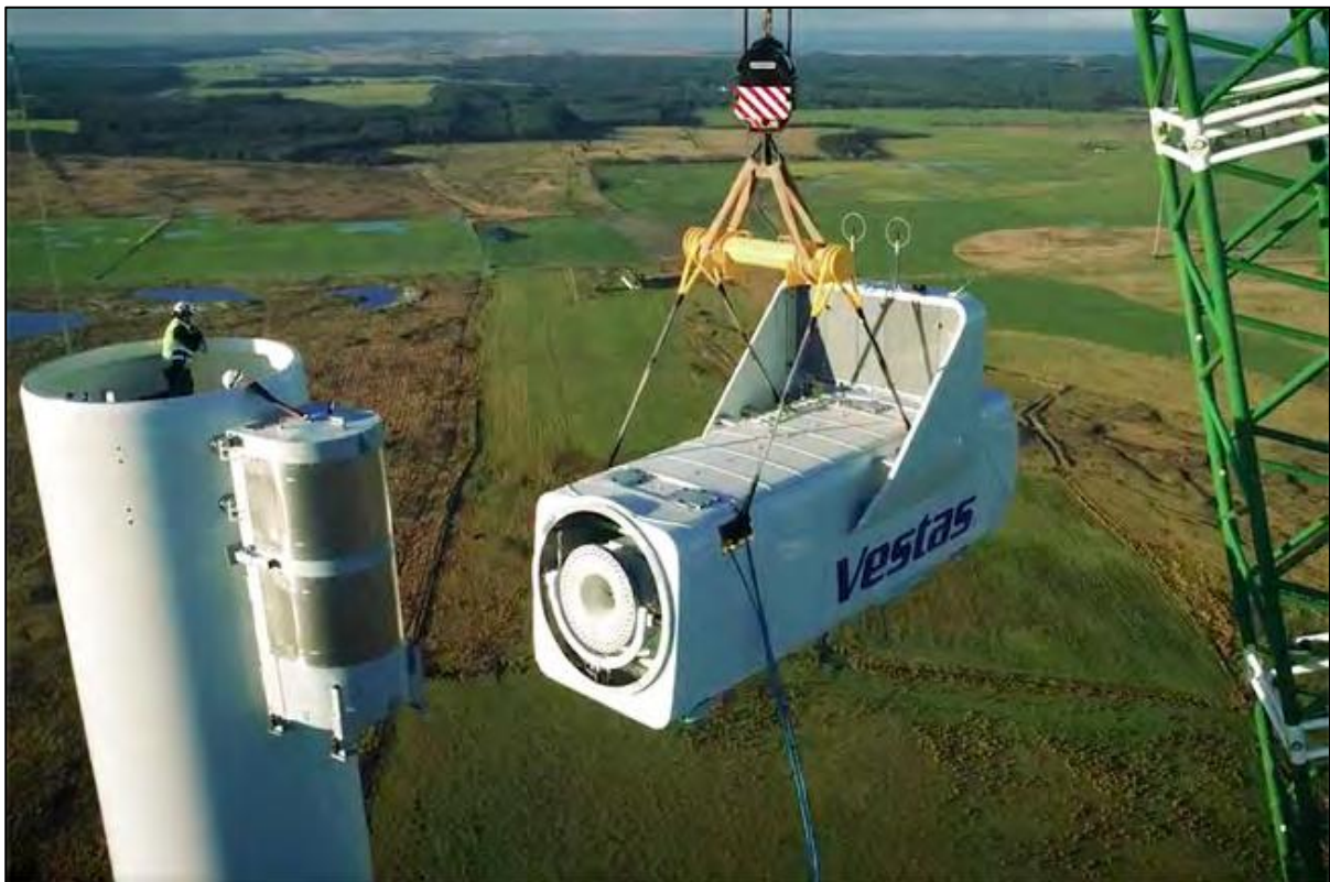
Obrázok 4: Postup pri výstavbe veternej elektrárne – montáž gondoly
