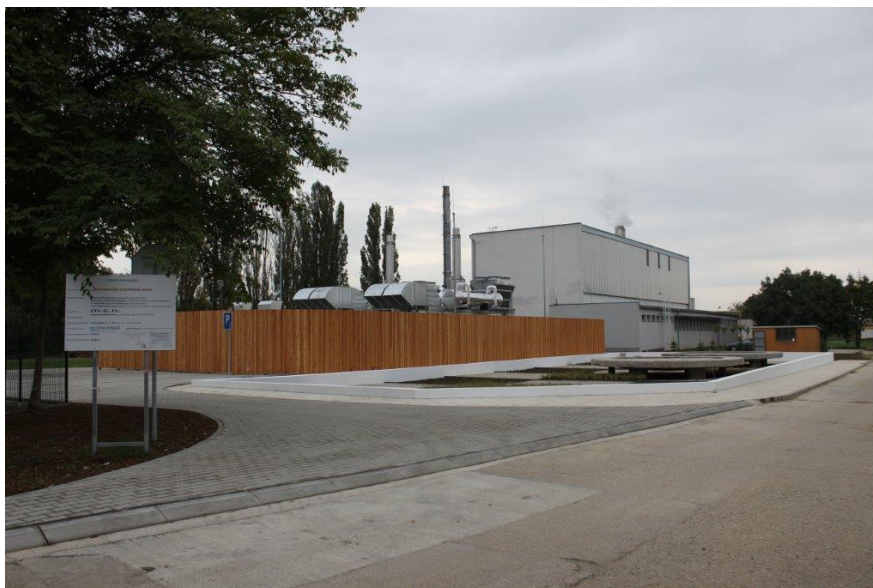
Obr. 11 Centrálny zdroj tepla CZT Nitra-Chrenová
