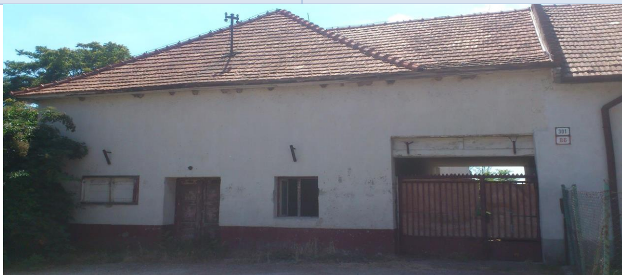
KD Janíkovce Hlavná (budova odpojená od energií)
