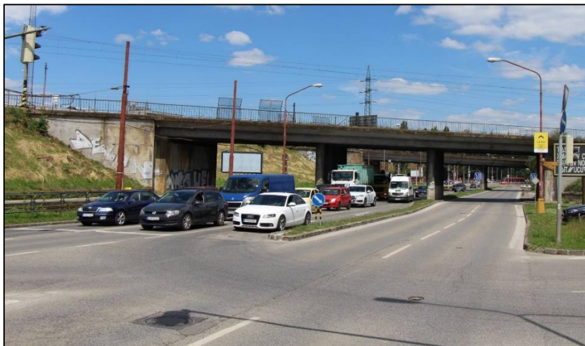
Obr. 2. Železničná trať vedená na mostnom objekte v žkm 58,636
