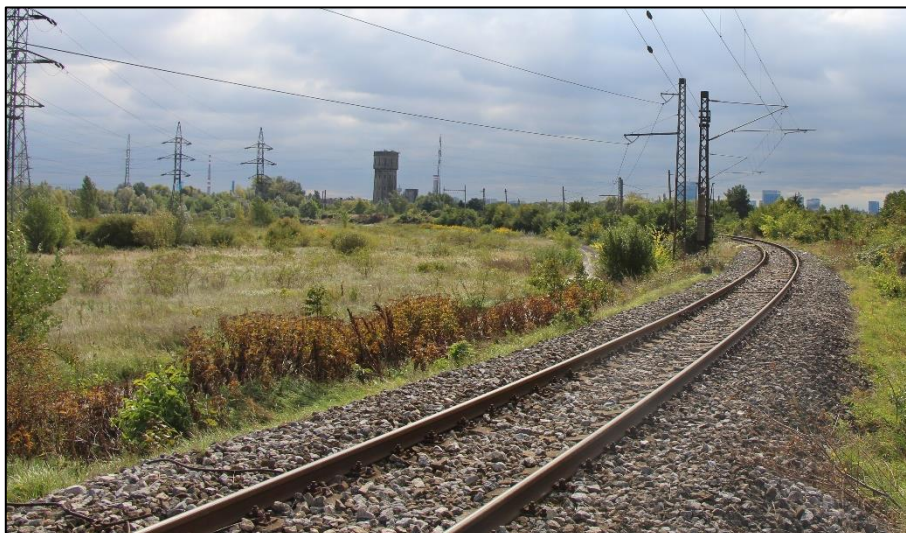
Obr. 11. Porasty nelesnej drevinovej vegetácie pozdĺž koridoru trate v žkm 2,432
