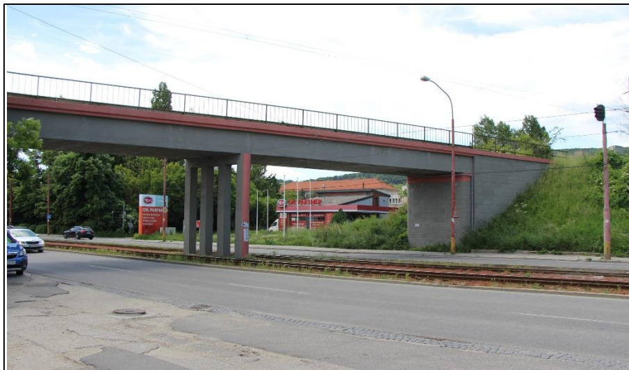
Obr. 4. Železničná trať vedená na mostnom objekte v žkm 3,699
