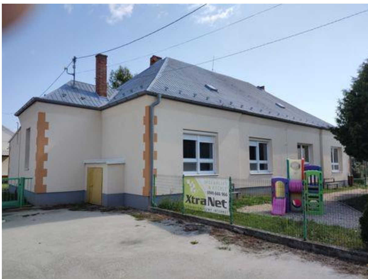
Budova materskej školy
