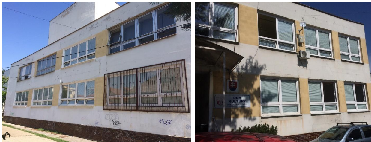
Obrázok 48: J strana, okná čiastočne vymenené; JV strana – vstup do DK, vymenené okná a dvere komplet
