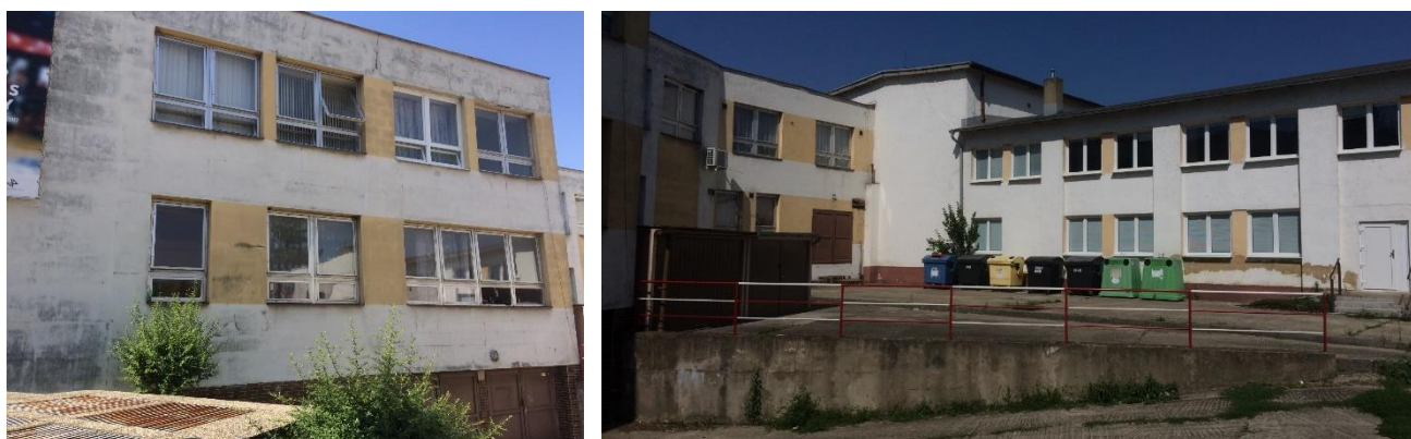
Obrázok 49: Z strana objektu a dvor, čiastočná výmena okien a dverí
