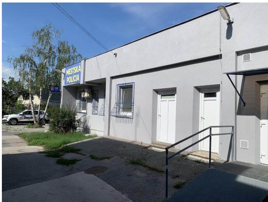
Obrázok 33: Zrekonštruovaná budova Mestskej polície Sered'
