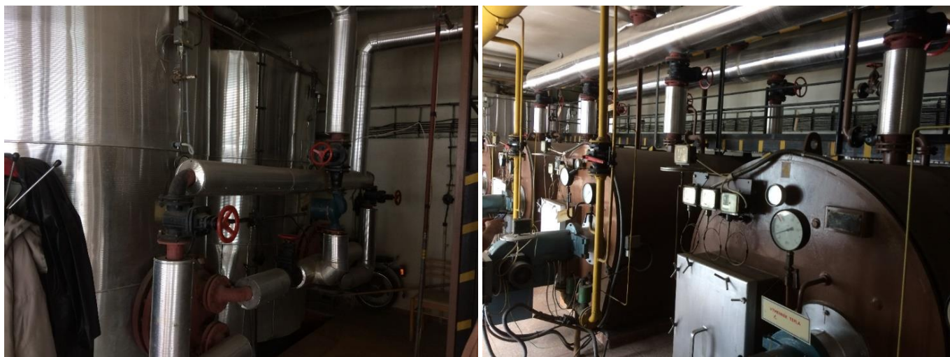
Obrázok 43: Kotolňa – vľavo akumulčné nádoby na TV, vpravo kotly
