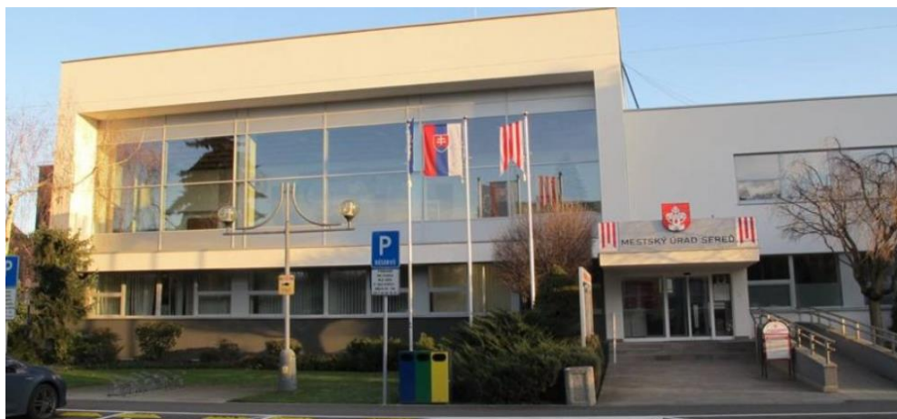
Obrázok 29: Budova mestského úradu po rekonštrukcii
