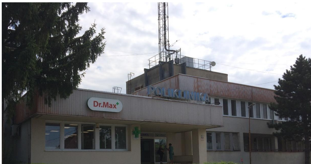
Obrázok 41: Vstup do polikliniky, staré okná (prízemie) a nové okná (poschodie)
