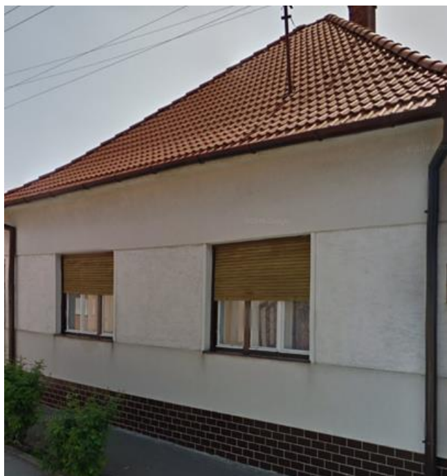
Obrázok 25: Čiastočne zrekonštruovaný dom – strecha, nezateplená fasáda, pôvodné okná
