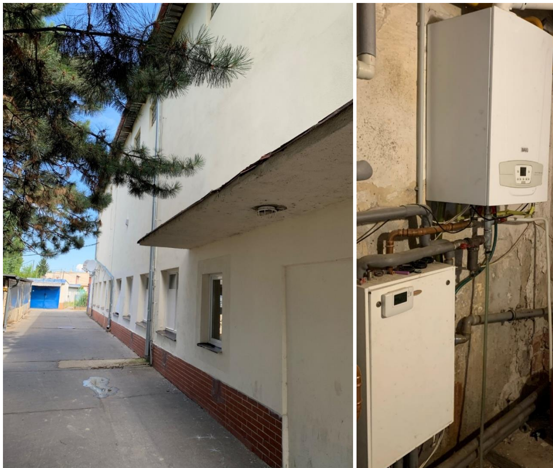
Obrázok 52: Futbalový štadión - pohľad zozadu na budovu šatní a súčasný stav prípravy tepla – kotol BAXI
