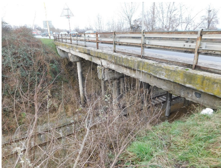
foto 3 zárez železnice v km 2,039 - 2,053 (december, 2020)
