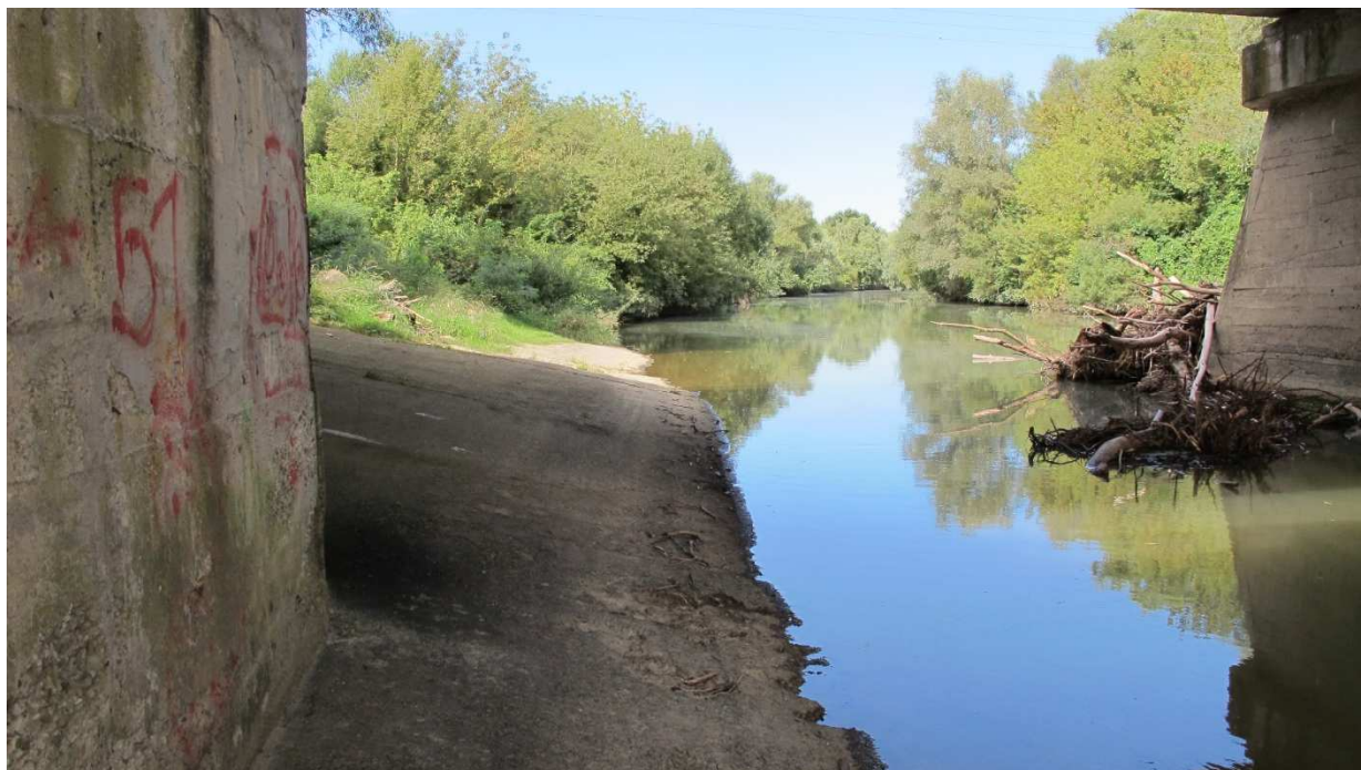
Pohľad spod rekonštruovaného mosta M6860 smerom na Šíravský kanál
