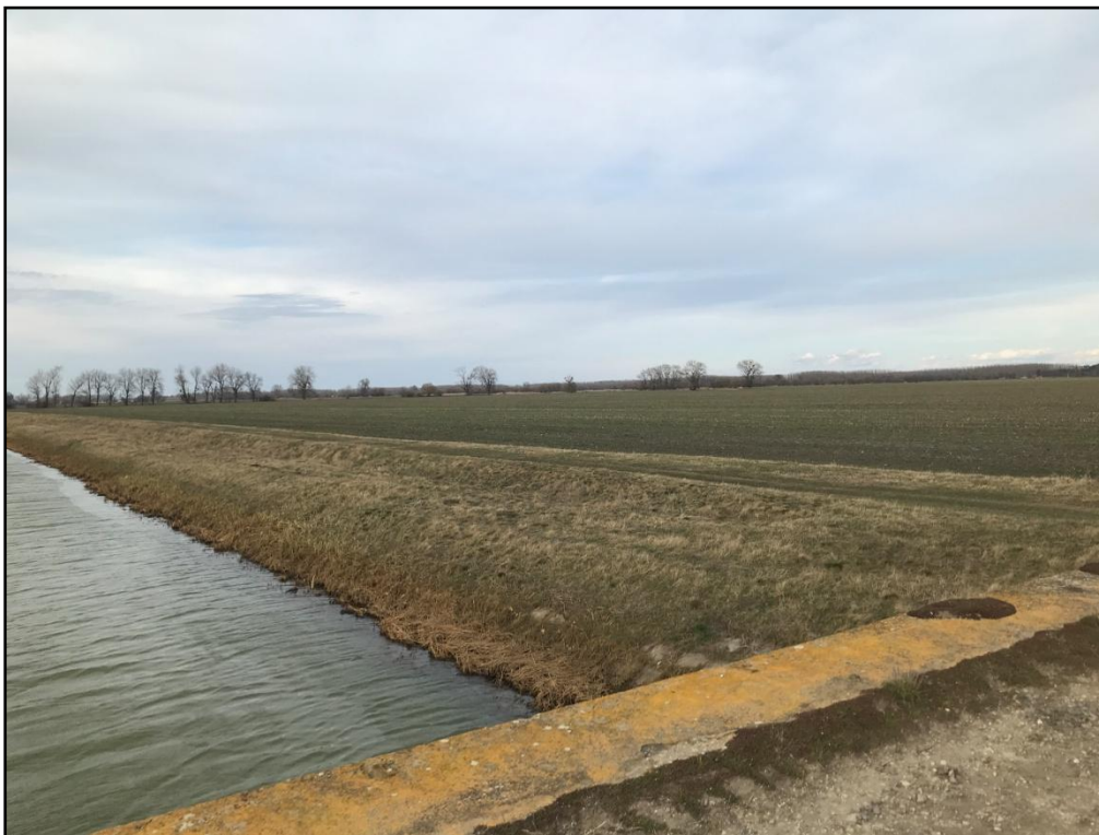
Foto 1 Pohľad na dotknuté územie, zo západnej strany, vľavo Kolárovský kanál, vľavo vzadu líniový porast popri bezmennom hydromelioračnom kanáli - severozápadná hranica dotknutého územia
