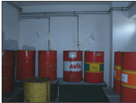
Obr. č. 4 Potrubné rozvody odsatých prevádzkových kvapalín do skladu NO
