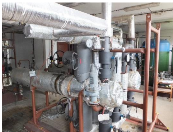
Obr. 18 Odovzdávacia stanica tepla - OST 3 – ROZKVET EG 5.
