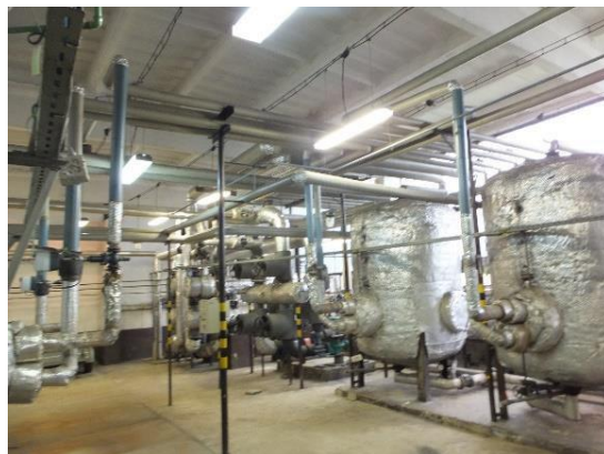
Obr. 17 Odovzdávacia stanica tepla - OST 2 – ROZKVVET EG II.
