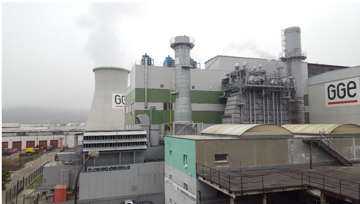
Obr. 3 Paroplynový cyklus Tepláreň Považská Bystrica, s.r.o.
