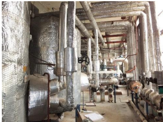
Obr. 14 Odovzdávacia stanica tepla - OST 10 – STRED E II.
