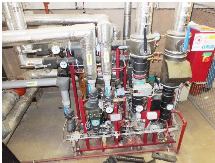
Obr. 23 Typická odovzdávacia stanica tepla (KOST)
