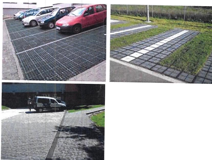
Materiálové zloženie dlažieb a spevnených plôch bude navrhnuté v dokumentácii pre stavebné povolenie. Dažďové vody z komunikácií a spevnených plôch budú zvedené voľne do terénu a do príhlahlého koryta potoka.
