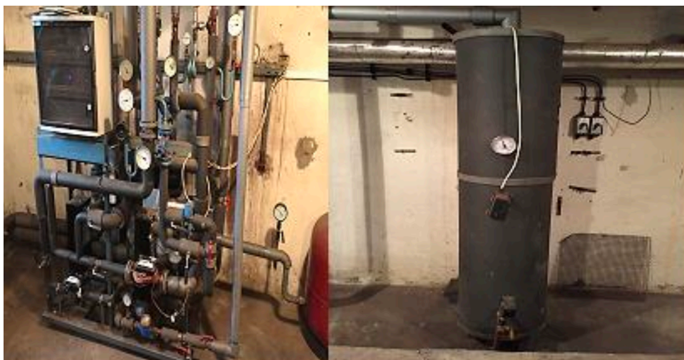
Obrázok 7 Aplikácia KOST s akumulacnou nádržou v dome na Pribinovej č. 121
