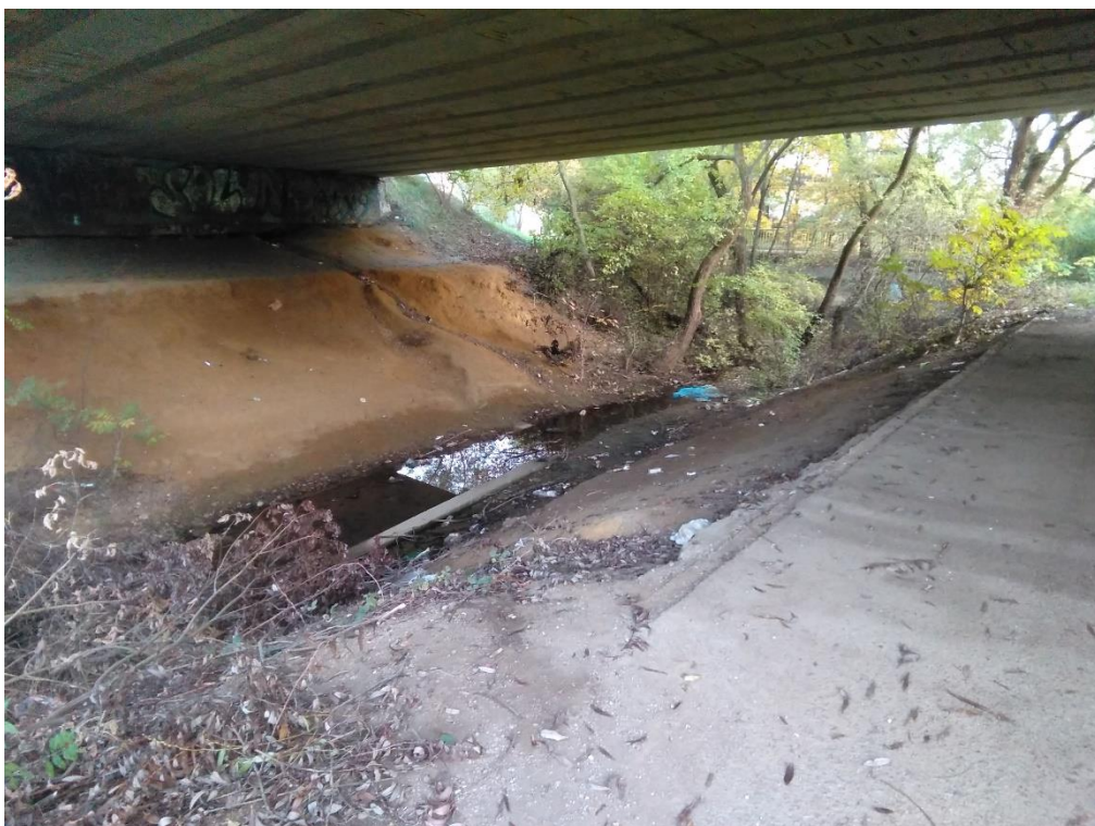
IV.úsek - záhradkárske osady - začína pod mostnými objektami cyklotrasy/chodníka a komunikácie Triedy KVP s prizmatickým spevneným korytom.
