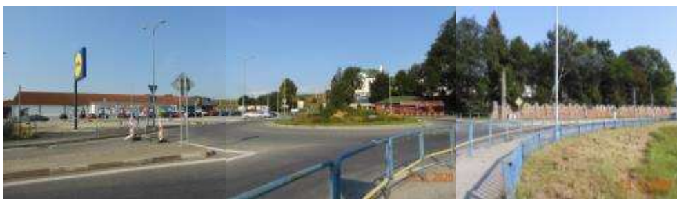
Koniec rekonštrukcie – okružná križovatka pred Lidlom.
