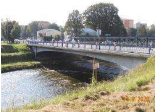
Most ev.č. I/66-064 navrhnutý na rekonštrukciu
