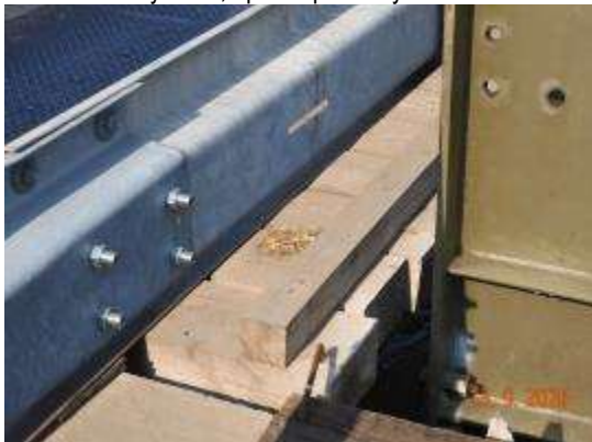
Konštrukcia dočasného mosta – drevené hranoly
