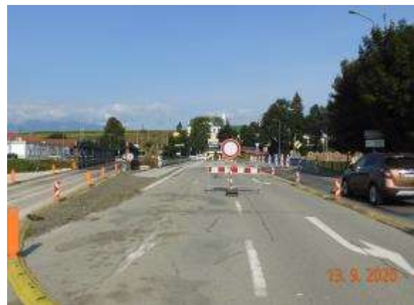
Premávka na pôvodnom moste usmernená do jedného jazdného pruhu
