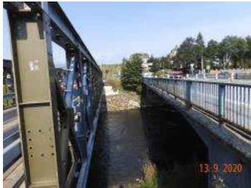
Vľavo dočasný most, vpravo pôvodný most ev.č.66-064
