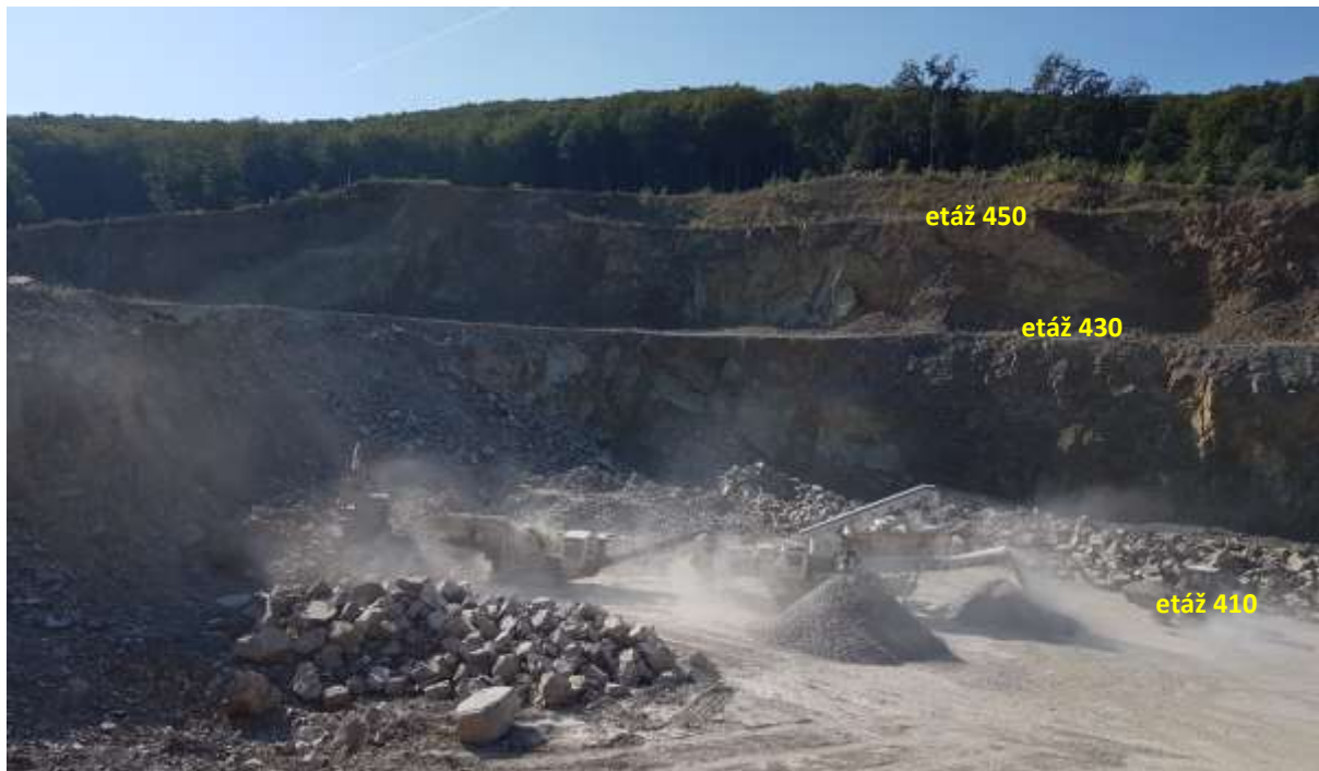
Obr. 4 Súčasný stav rozfárانيا ložiska
