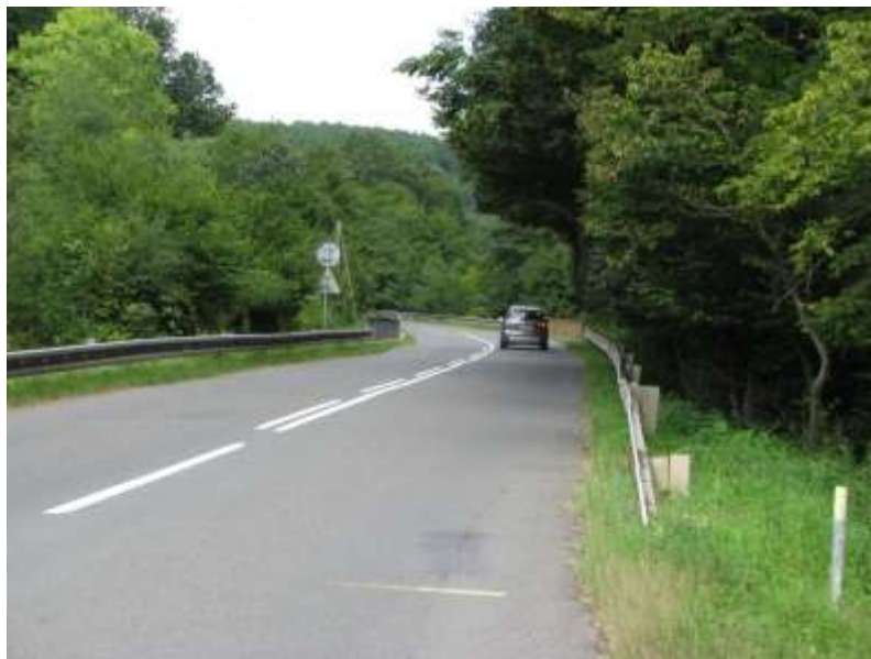
most ev. č. 51-168 na ceste I/51
