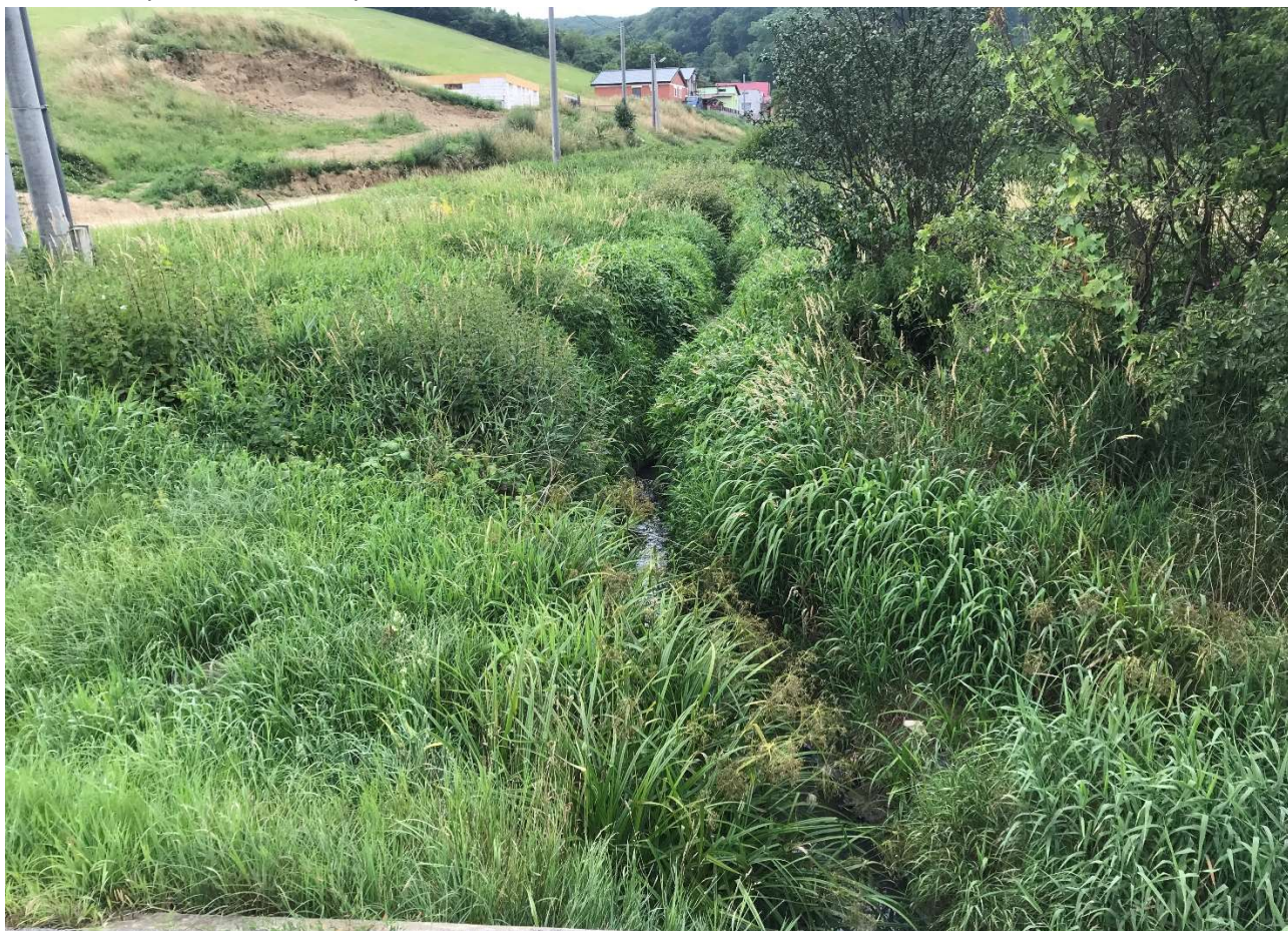
Foto 1: Koryto Tekeriškého potoka tesne nad mostom 020-058
