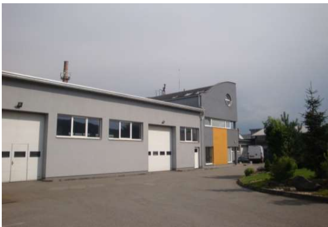
Foto č. 4: Viacúčelová hala – vpredu a vedľa nej vpravo Administratívna budova
