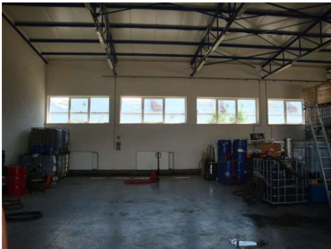
Foto č. 7: Viacúčelová hala, v ktorej bude umiestnené Deemulgačné a neutralizačné zariadenie DNZ 10
