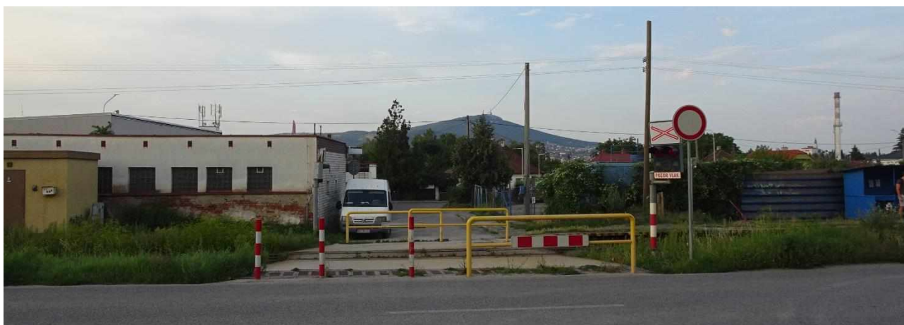
Obrázok 44 Priecestné zabezpečovacie zariadenie pri železničnej zastávke Nitra zastávka
