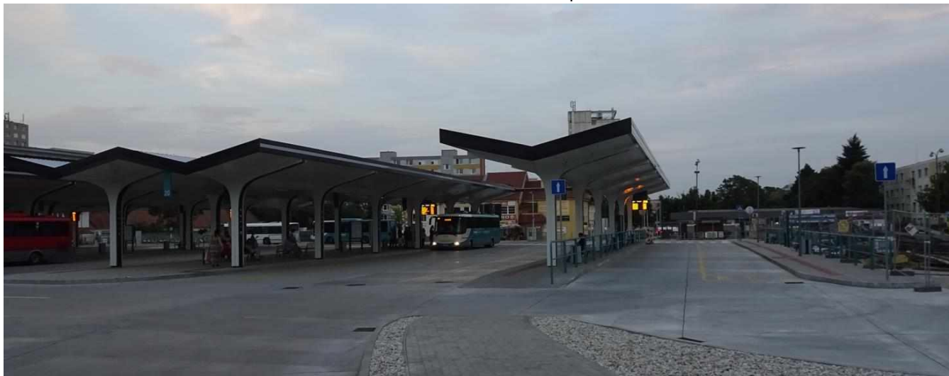
Obrázok 53 Autobusová stanica Nitra v procese rekonštrukcie
