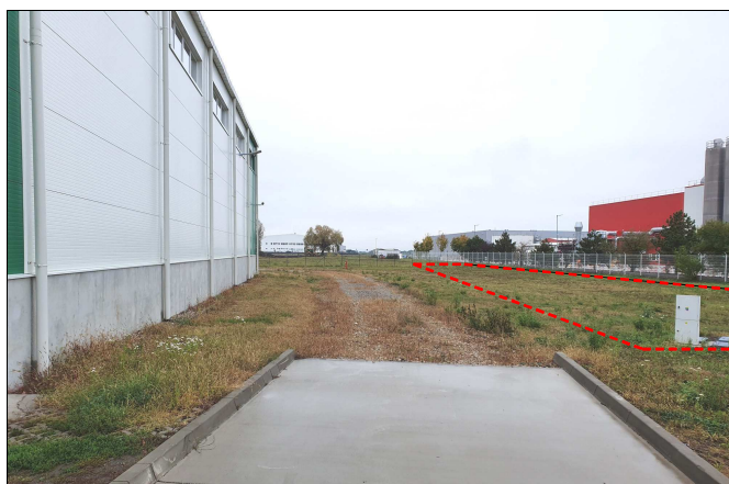
Obr.6: Juhozápadná hrana výrobnjej haly s vyznačením plochy budúceho rozšírenia parkovacích miest (pohľad južným smerom)
